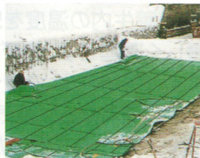
ダム放水口修繕工事
