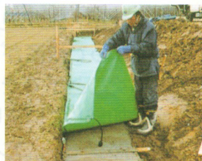
均しコンクリート
