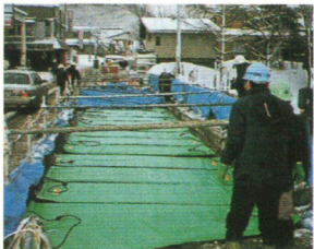
橋梁改良工事
